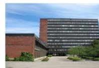
Eilert Sundts hus
