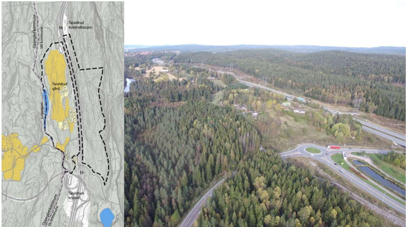
Figur 1: Taraldrud. Tomten ligger på begge sider av E6 på Taraldrud, like sør for kommune-grensen mot Oslo.
