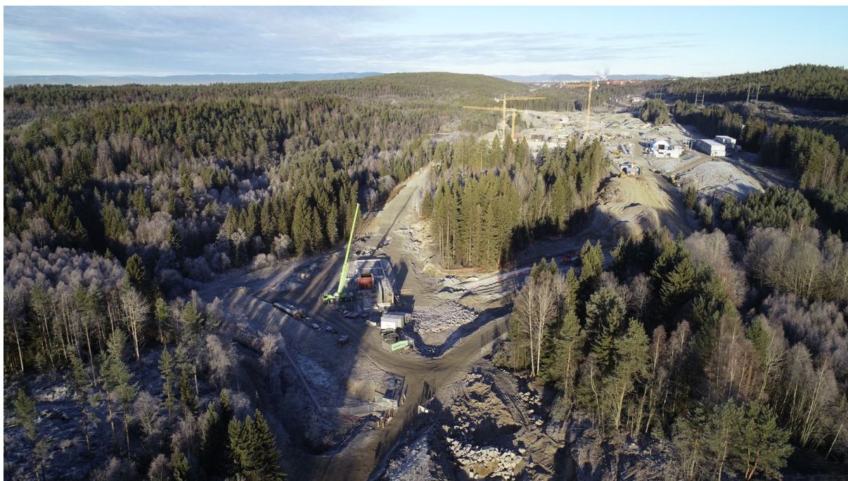
Bilde 1: Adkomstbygget uke 48. Betongarbeid pågår.
