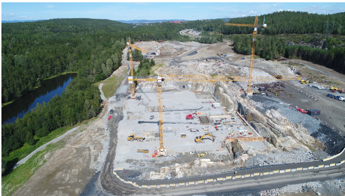
Bilde 1: Byggegrøp for hovedbygget uke 32. 3 tårnkraner er montert i inneværende periode.
