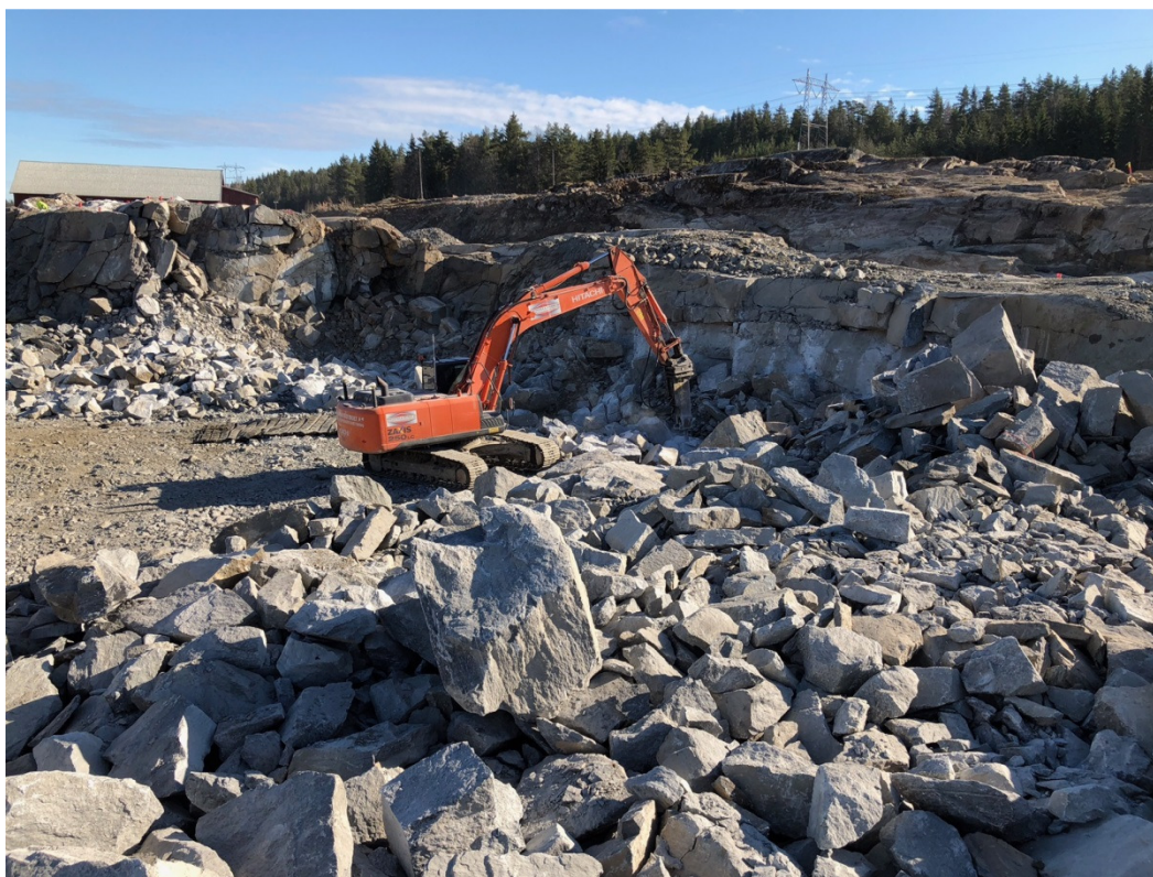
Bilde 1: Sprengningsarbeider for hovedbygget pågår.
