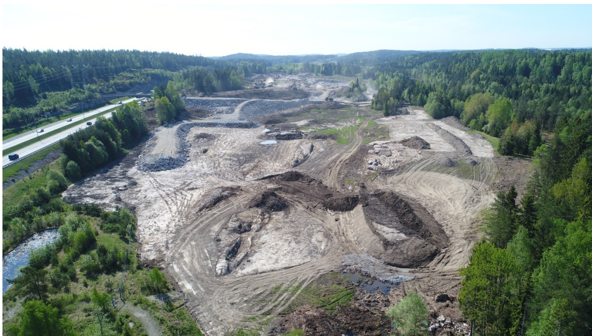
Bilde 2: Matjord er ranket og det pågår arbeid med utlegging av steinmasser i fyllinger
