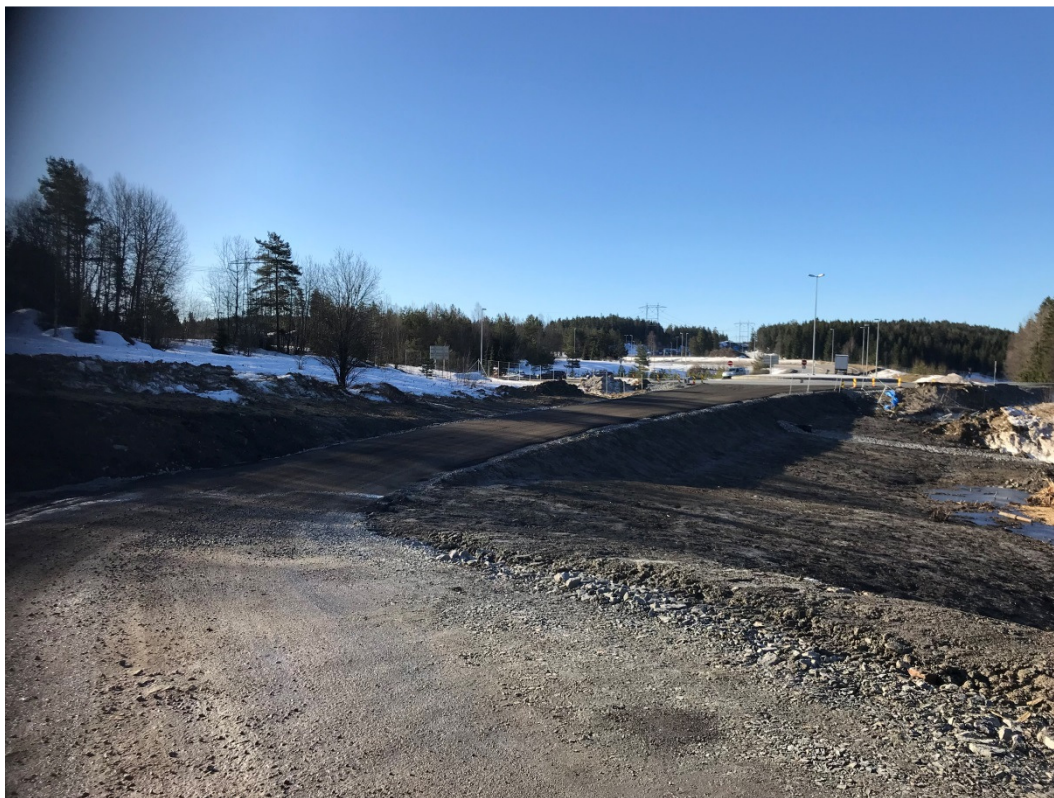
Bilde 1: Ny avkjøring fra rundkjøringen i Taraldrudkrysset er etablert
