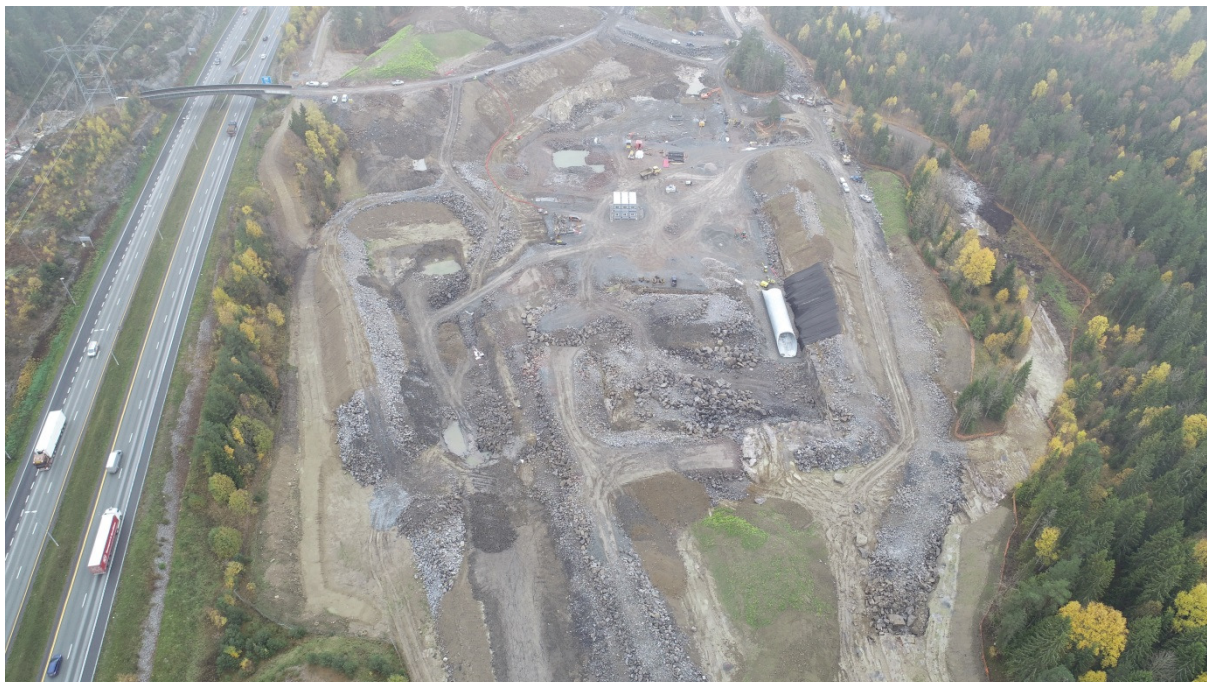
Bilde 2: Treningsområdet uke 42. Sprengningsarbeidet øst for E6 kan også skimtes.
