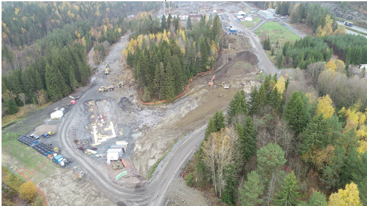
Bilde 1: Adkomstbygget uke 42. Fundamenteringsarbeidet pågår.
