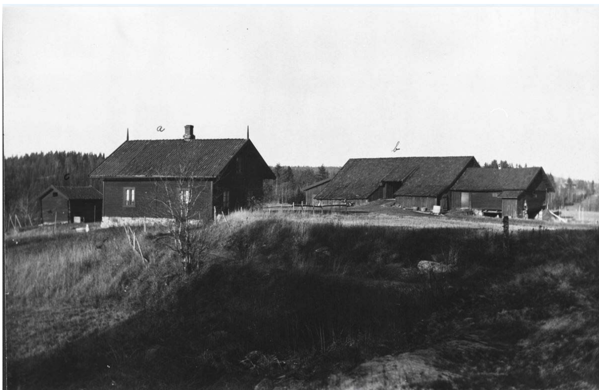
Figur 3-6 Taraldrudhytta 1930. Av bygningene på bildet står kun driftsbygningen igjen i dag. Foto: Skarpmoen atelier/ Akershusbasen. Kilde: Digitalmuseum.no
