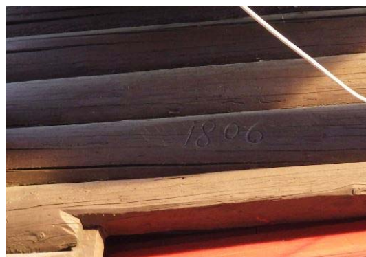
Figur 4-5 Byggeår 1806 er risset inn over døra
