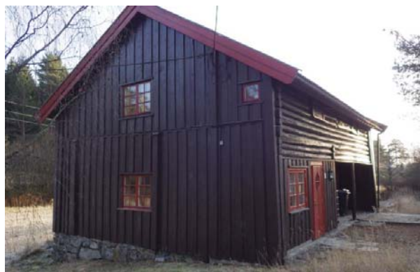
Figur 4-3 Fasade mot nord
