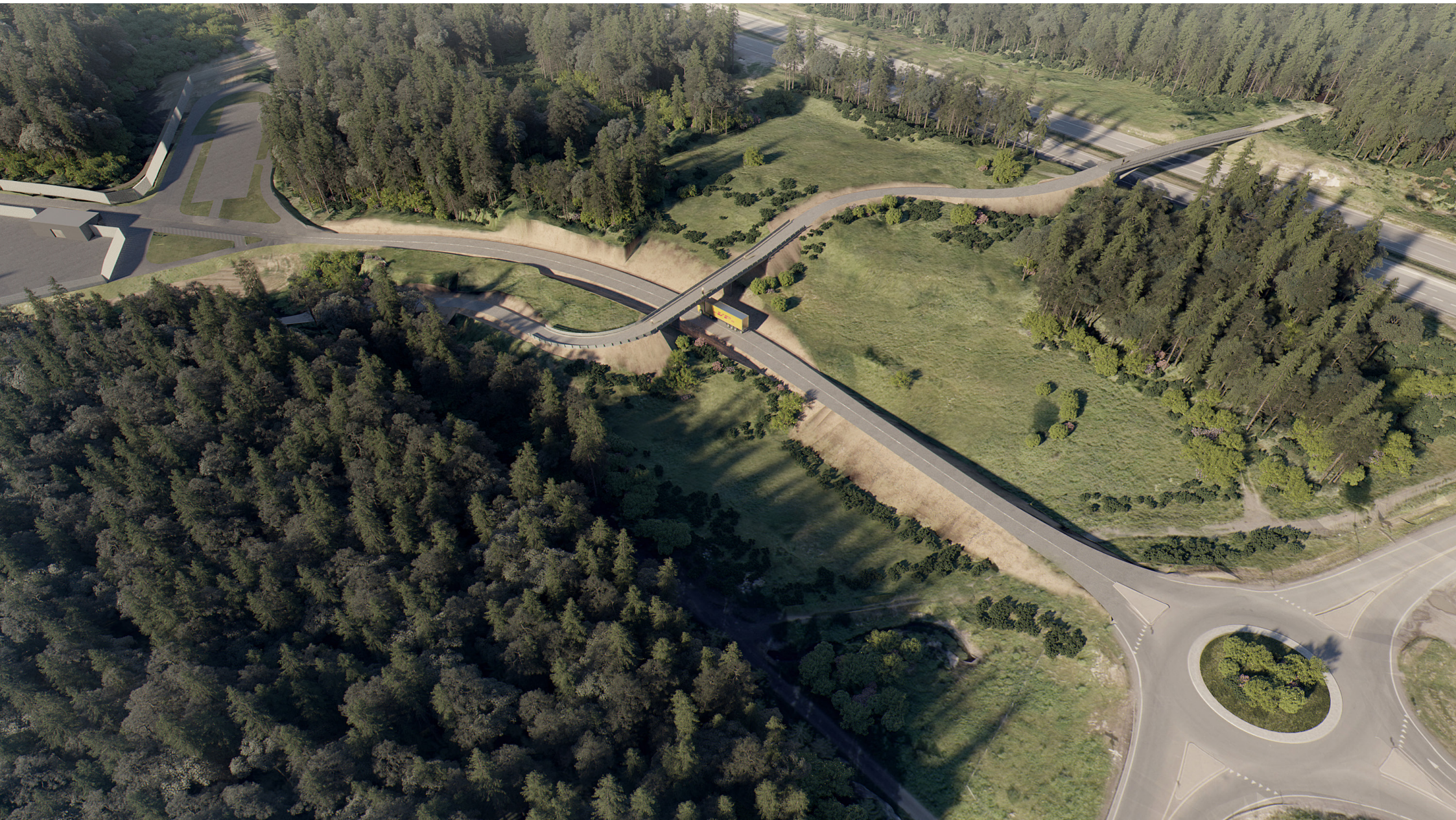
Figur 12: Illustrasjon av friluftsbua over atkomstveien. Turveien legges på bru over atkomstveien og kobles direkte til eksisterende bru over E6 (Søndre Taraldrud bru).
