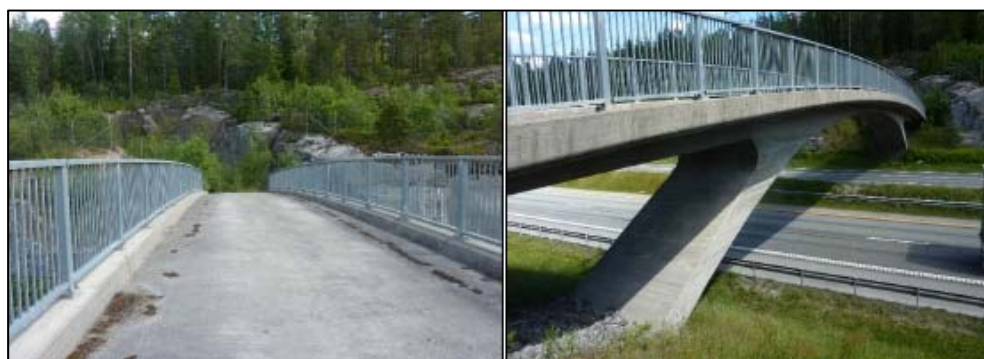
Figur 16: Eksisterende bru over E6 (kilde bilde: Aas-Jakobsen)
