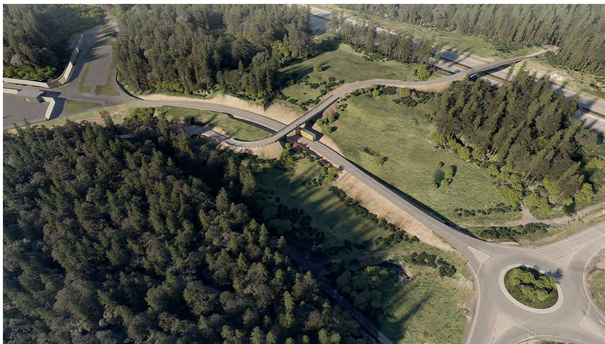
Figur 2-10 Illustrasjon av turveien som krysser atkomstveien på bru og knyttes direkte på eksisterende bru over E6. Figur: Nordic Office of Architecture.
